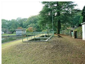
流入水量調整の着水井
