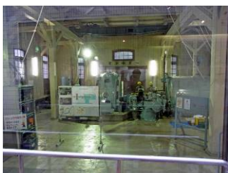
発電所内点検作業(ガラス越し)
